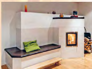
Der Speicherofen heizt das ganze Haus
